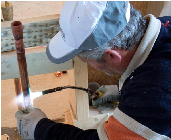
Abb. 4: Gabriele, der Sanitärinstallateur aus L'Aquila
