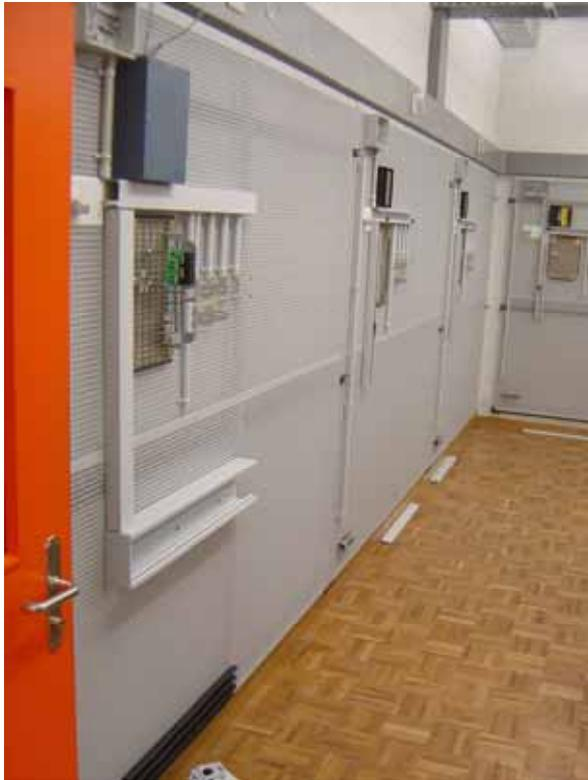
Im Jahr 2005 hat der Verband SELIV versuchsweise eine Montagegitterwand beschafft. Der Vorteil dieser Montageunterlage liegt in ihrer Doppelfunktion. Bei dieser Konstruktion ist es möglich, Elektroinstallationen auszuführen oder mit speziellen Modulen Steckübungen aufzubauen. Nach einer einjährigen Testphase konnten im Kurs Erfahrungen gesammelt werden. Dabei wurden folgende Erkenntnisse gewonnen:
