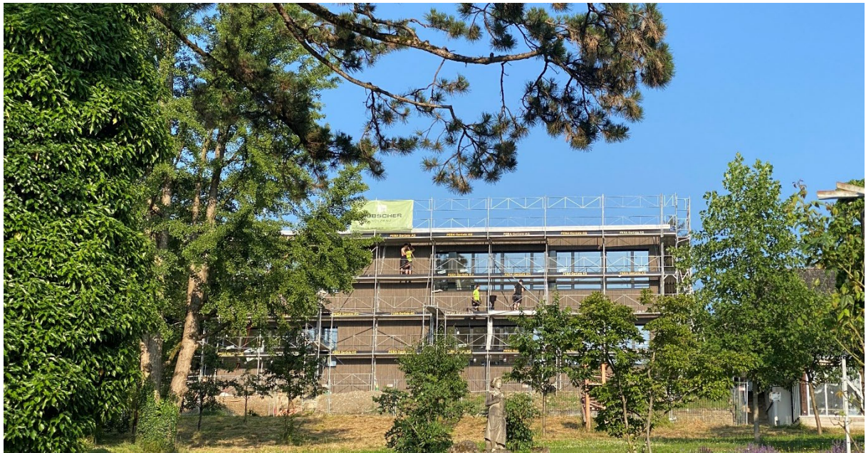
Ergänzungsbau «Haus Mentona», Ende Juni 2024.
